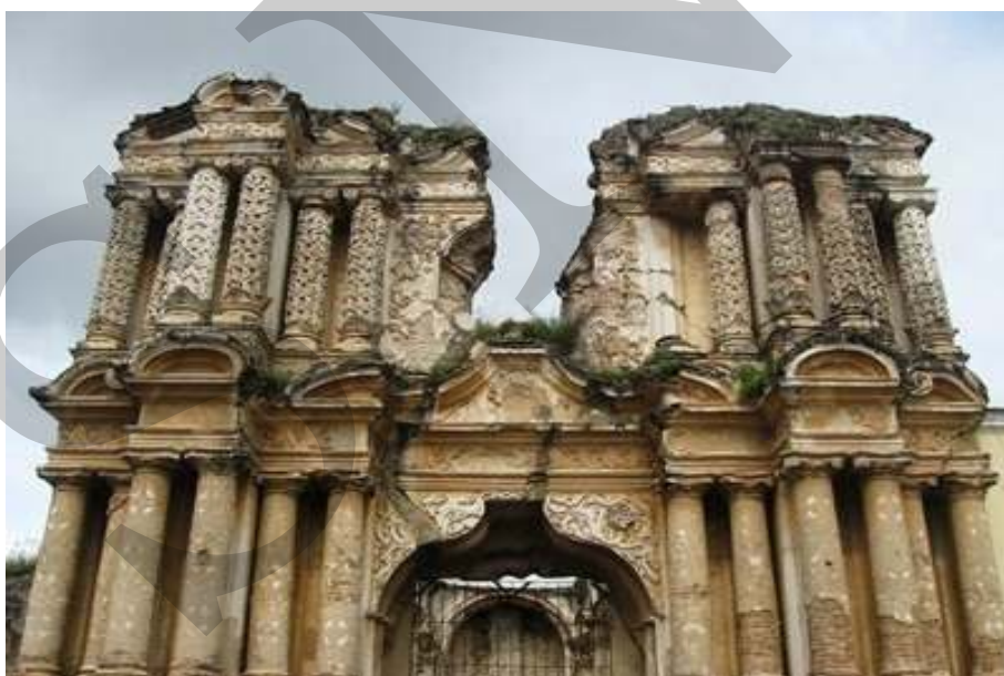
FIGURA NO. 16 RUINAS DE EL CARMEN, LA ANTIGUA GUATEMALA
