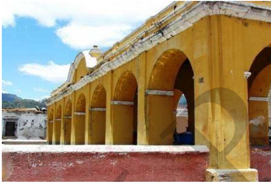
FIGURA NO. 17 TANQUE LA UNIÓN, LA ANTIGUA
