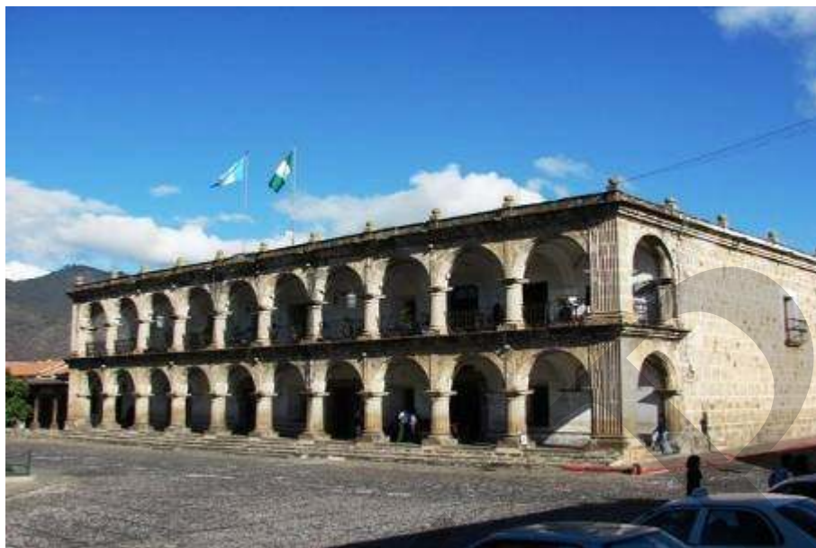
FIGURA NO. 15 PALACIO DEL AYUNTAMIENTO, LA ANTIGUA GUATEMALA
